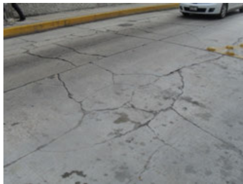
Foto 20. Calle 31 por calle 28, Col. Centro.
