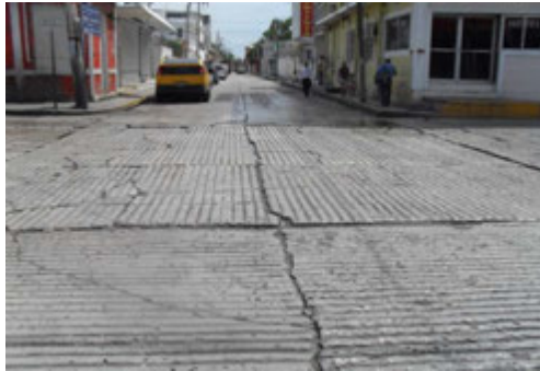
Foto 21. Calle 41 con esquina de la calle 22
