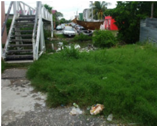
Foto 13. Calle Rosas, puente el triunfo
