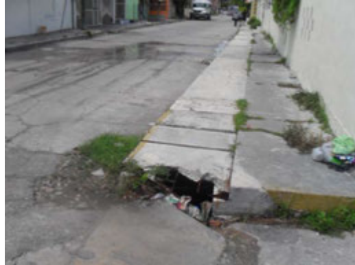
Foto 27. Calle 41 por calle 46, Tecoluitla.
